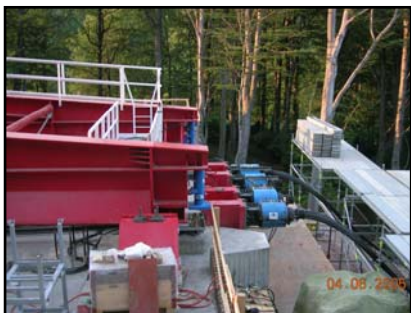
▲ Vysouvací a přizvedávací zařízení.
