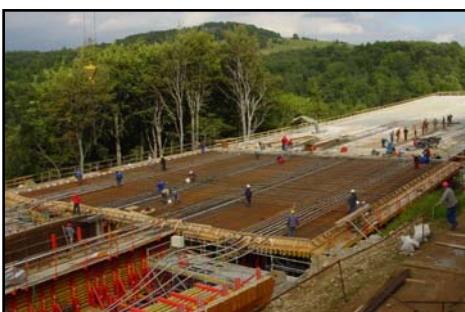
▲ Primární a příčné předepnutí horní desky.
