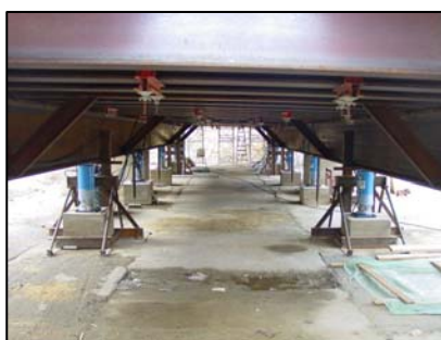
▲ Rektifikovatelnost je zajištěna hydr.lisy.
