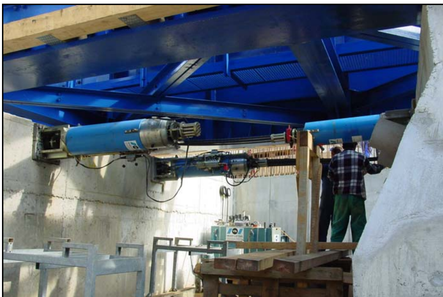
▲ Instalace VSL vysouvacího zařízení, synchronizované tažné a brzdné lisy.
