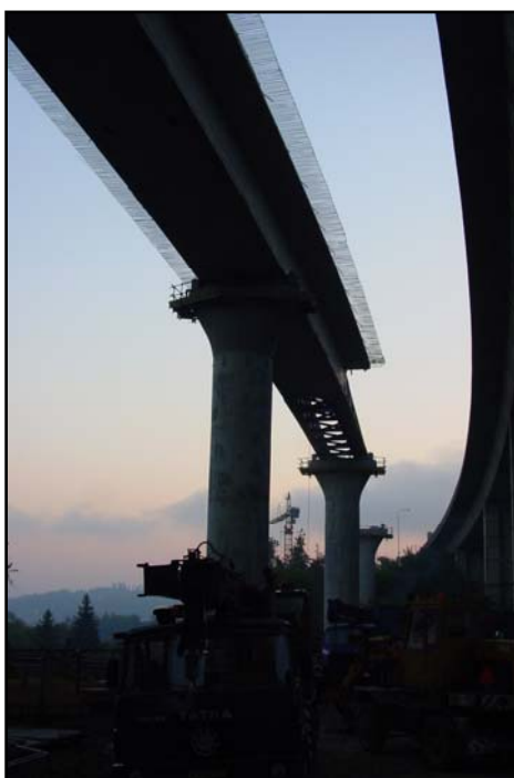
▲ Konzoly horní desky budou dobetonovány po dojezdu a osazení bočních prefabrikátů
