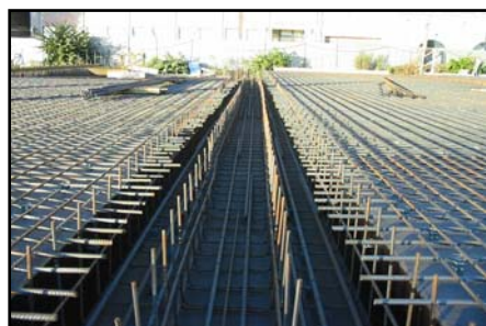
▲ Uložená spodní výztuž.
