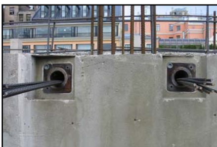
▲ Odbedněné čelo, přesah lan pro napínání.
