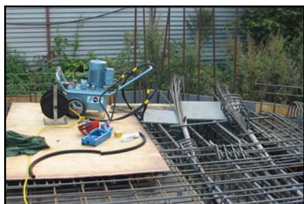
▲ Ukládka pasivních kotev H 5-12.
