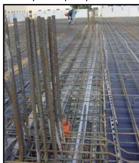
▲ Kanálky pod horní výztuží
