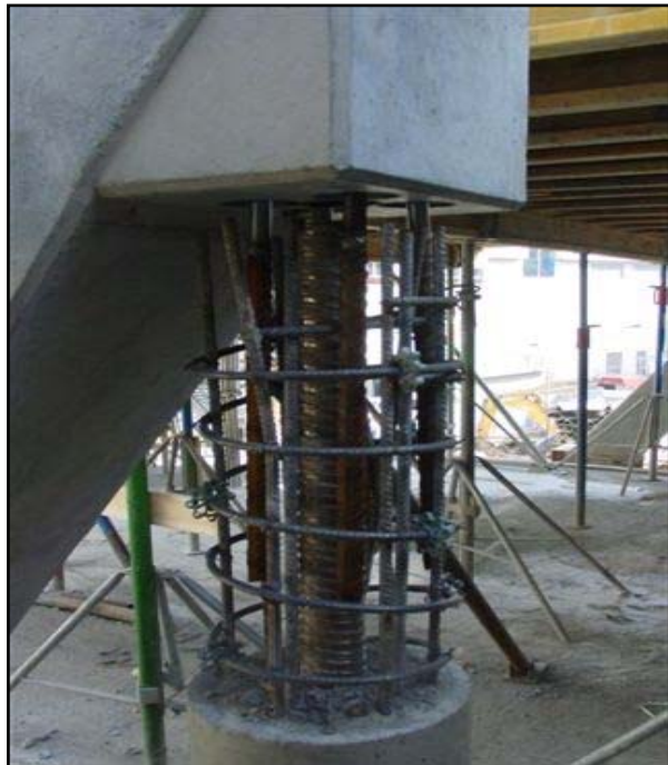
▲ Kabelový kanálek v budoucím závěsu
