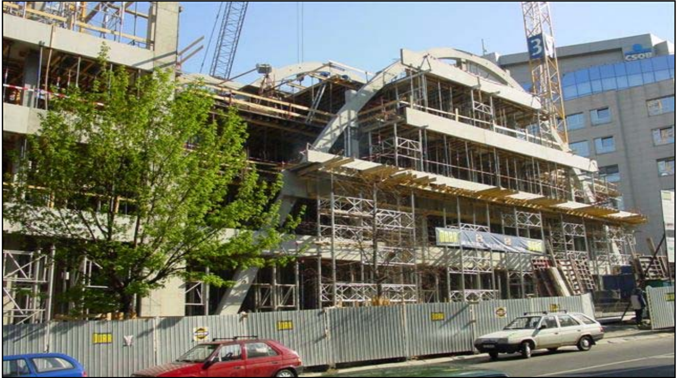
▲ Objekt Pankrác House ve výstavbě.
