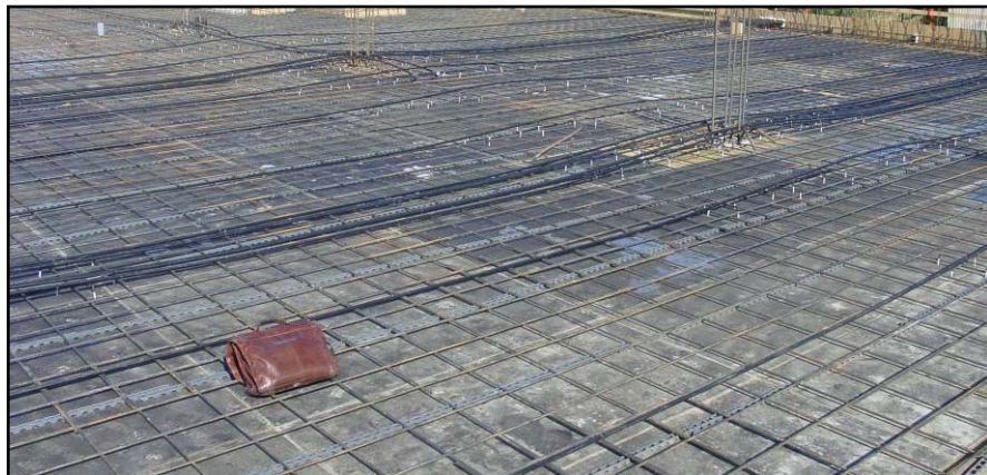
▲ Uložená předpínací lana před zaklopením horní výztuži
