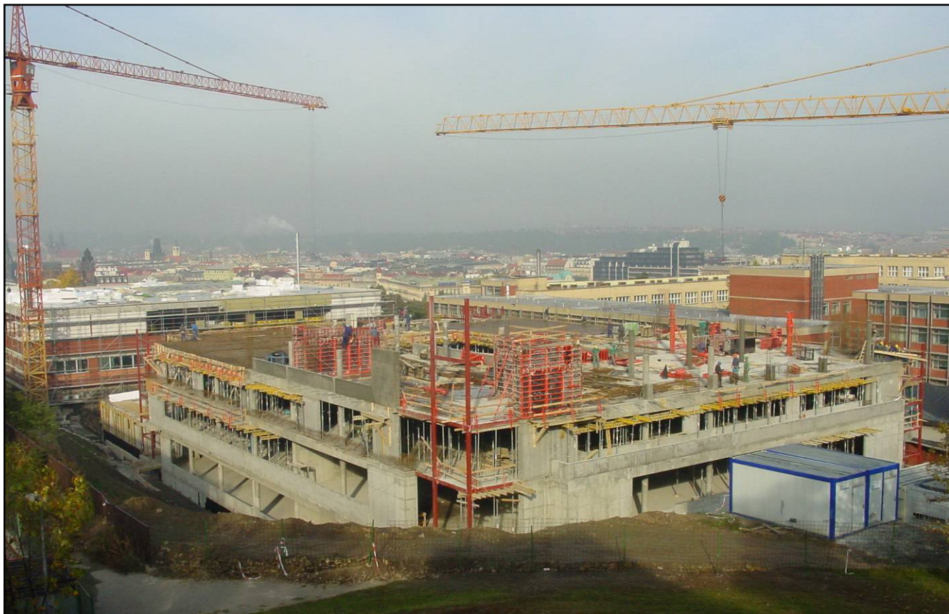
▲ Rajská budova VŠE ve výstavbě
