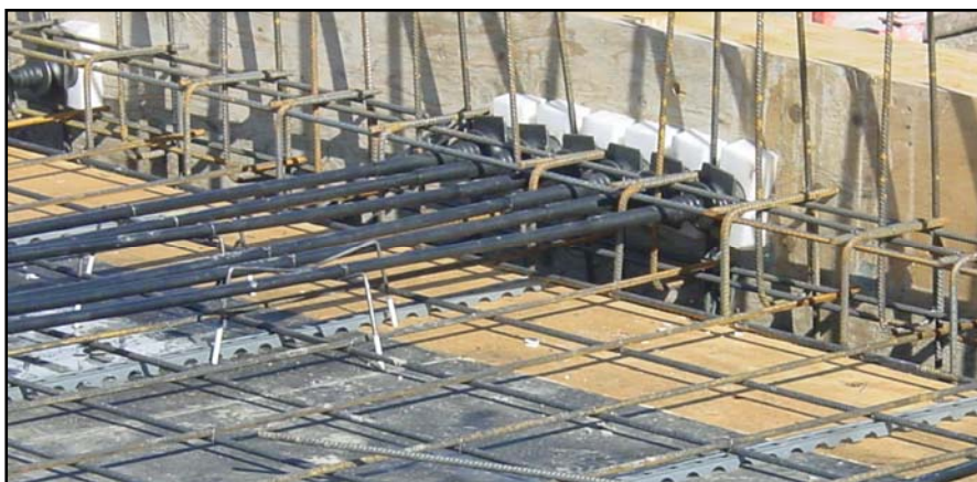
▲ Aktivní kotvy S 6 v čele bednění
