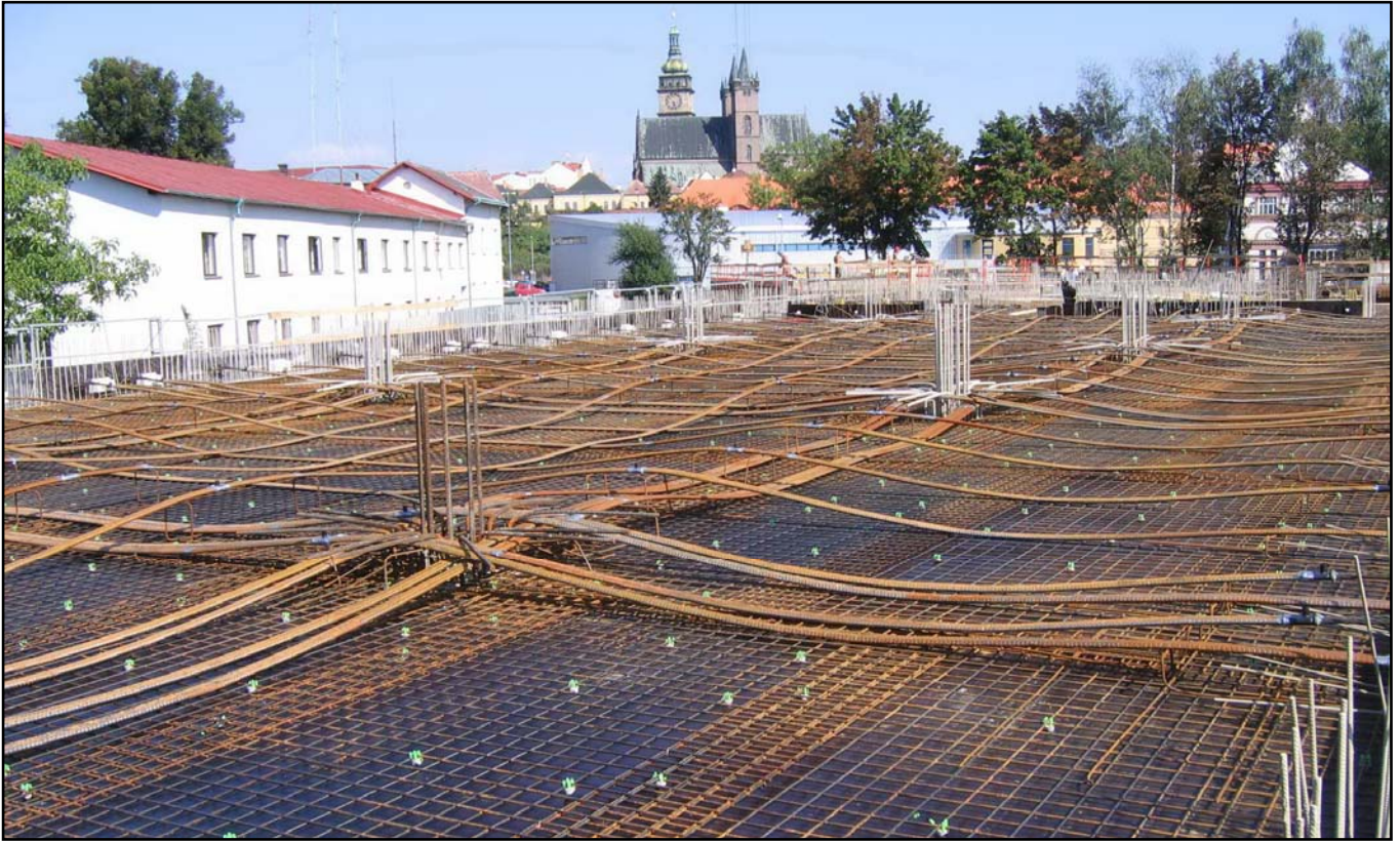
▲ Budova KIC ve výstavbě
