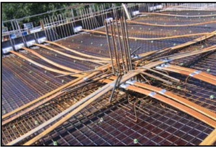
▲ Uložené kabelové kanálky
