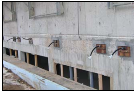
▲ Čelo konstrukce před injektáží kabelů
