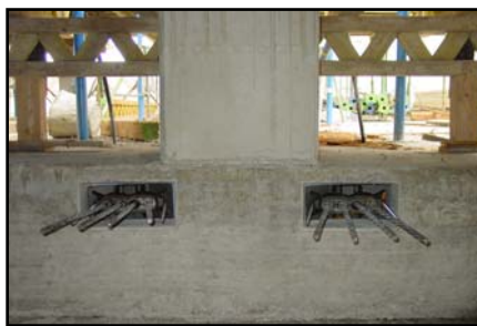
▲ Aktivní kotva SO 6-4 před napínáním.
