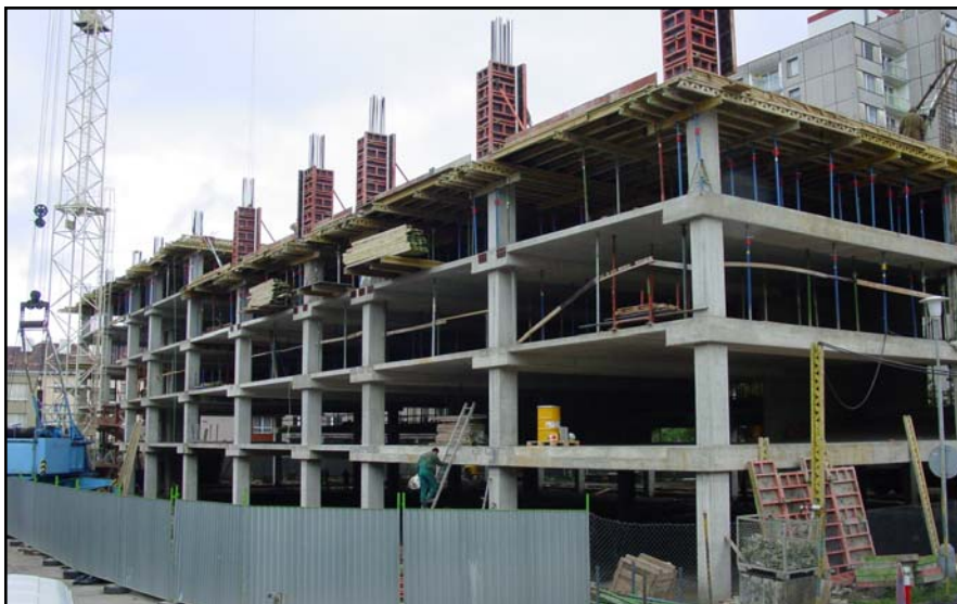
▲ Boční pohled, čela trámů po zainjektování nebo osazenými injektážními kryty.
