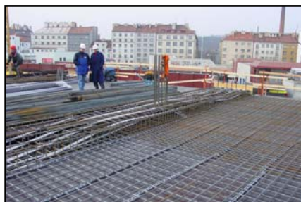
▲ Uložené kabely před zaklopením výztuží.
