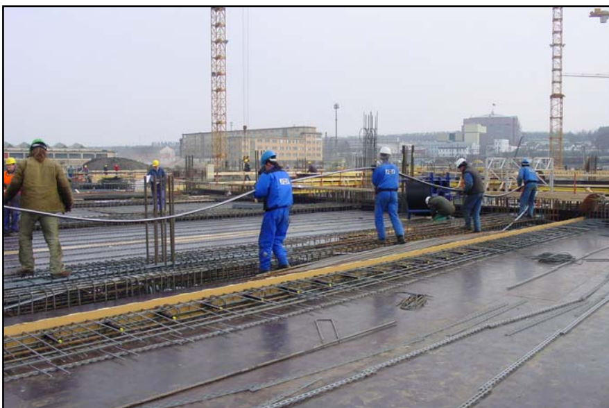
▲ Ukládka prefabrikovaných kabelů do konstrukce..
