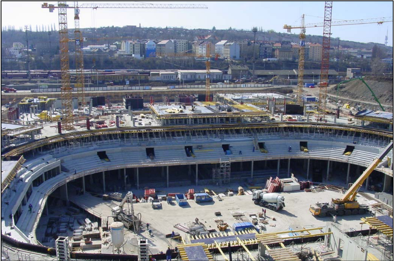
▲ Hala Sazka ve výstavbě.
