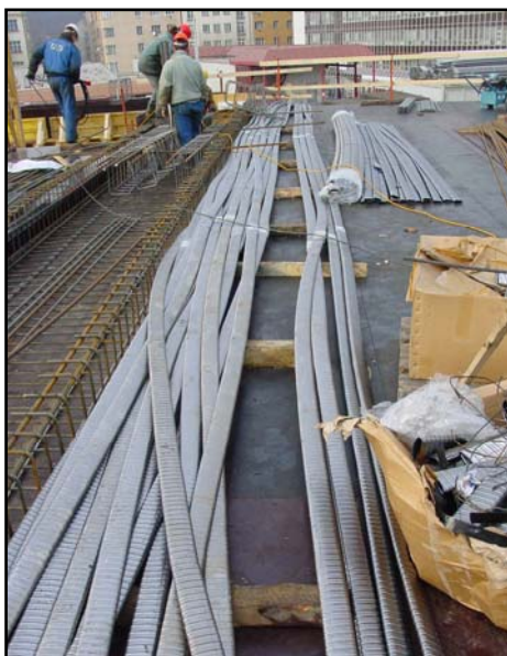
▲ Prefabrikace předpínacích kabelů SO 6-4.
