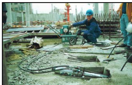
▲ Provádění předpínání v kapse průvlaku
