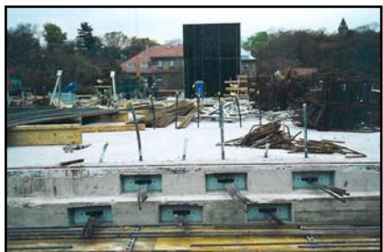
▲ Aktivní kotva SO 6-4 po odbednění čela
