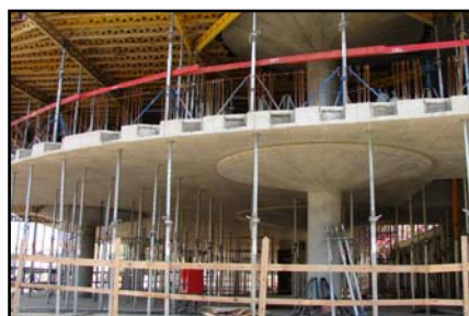
▲ Kotevní kapsy po injektáží kabelů
