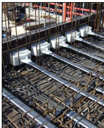
▲ Aktivní a pasivní kotvení v čele desky
