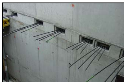
▲ Kotevní kapsy před injektáží kabelů
