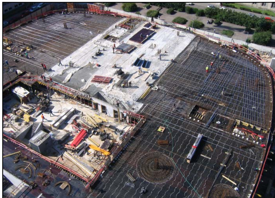
▲ Jednotlivé betonážní úseky v různé fázi rozpracovanosti
