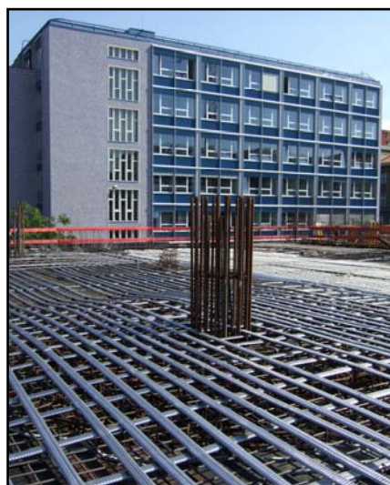
▲ Předpínací kabely v oblasti hlavice
