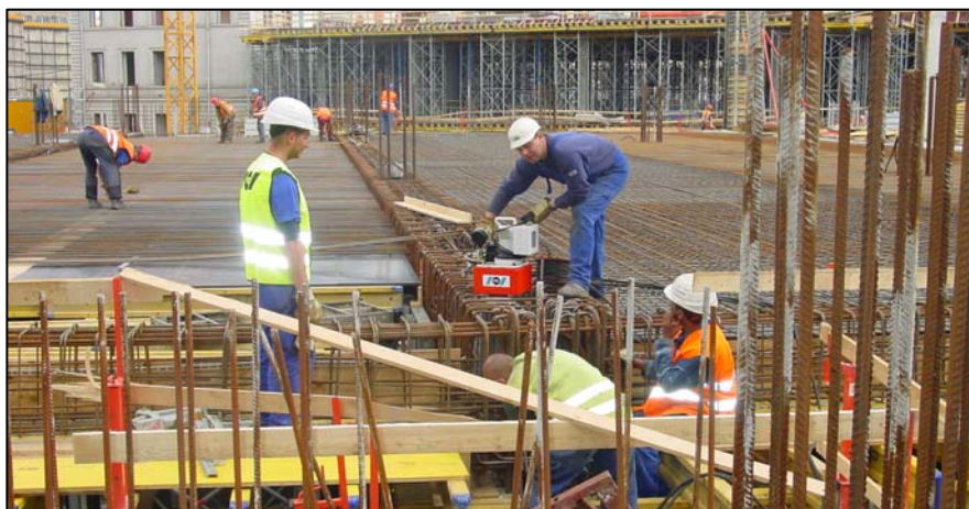
▲ Předpínací práce probíhají současně s ukládáním betonářské výztuže.
