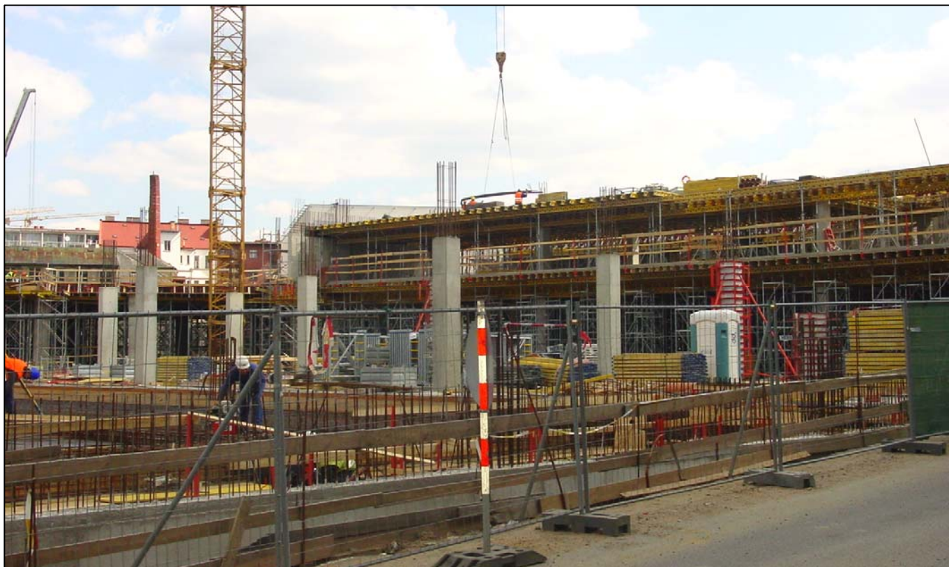
▲ Budova Fórum Liberec ve výstavbě.
