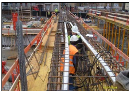
▲ Práce uvnitř bednění trámu.
