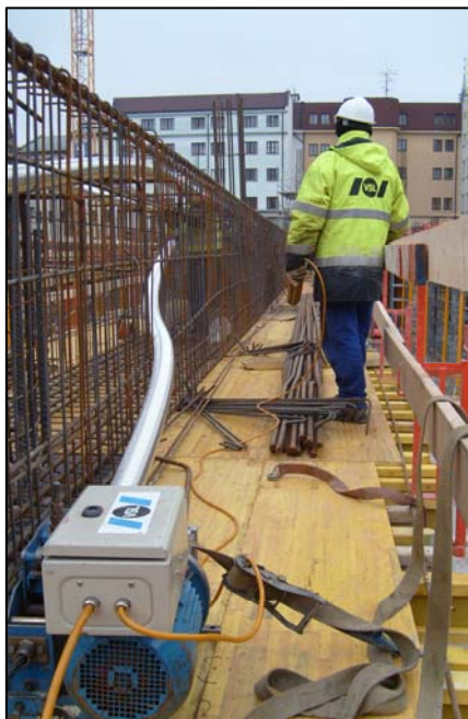
▲ Prostrkání předpínací výztuže.
