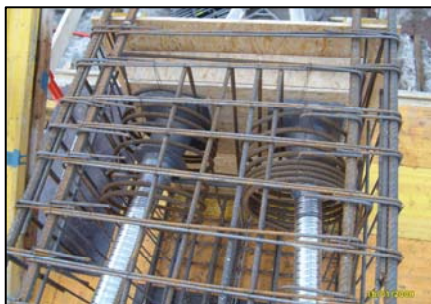
▲ Pozice aktivních kotev v čele bednění.
