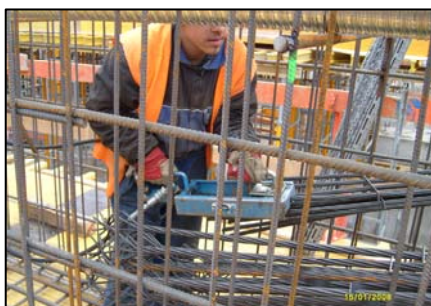
▲ Zhotovení rozpletu pasivních kotev.
