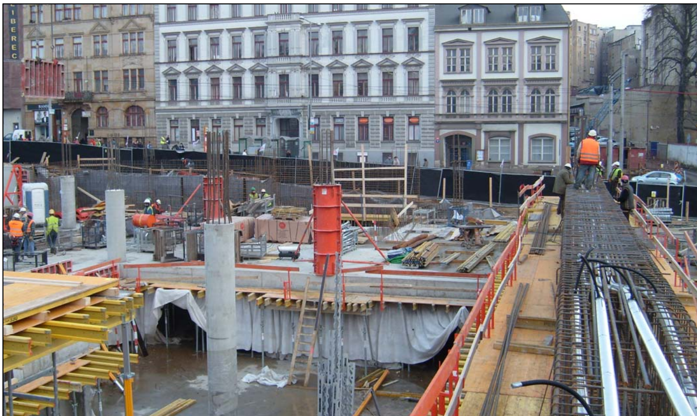
▲ Ukládka přechodového trámu prováděna v předstihu před ukládkou stropní desky.
