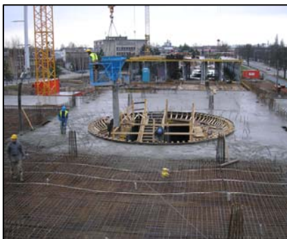
▲ Betonáž stropních konstrukcí.
