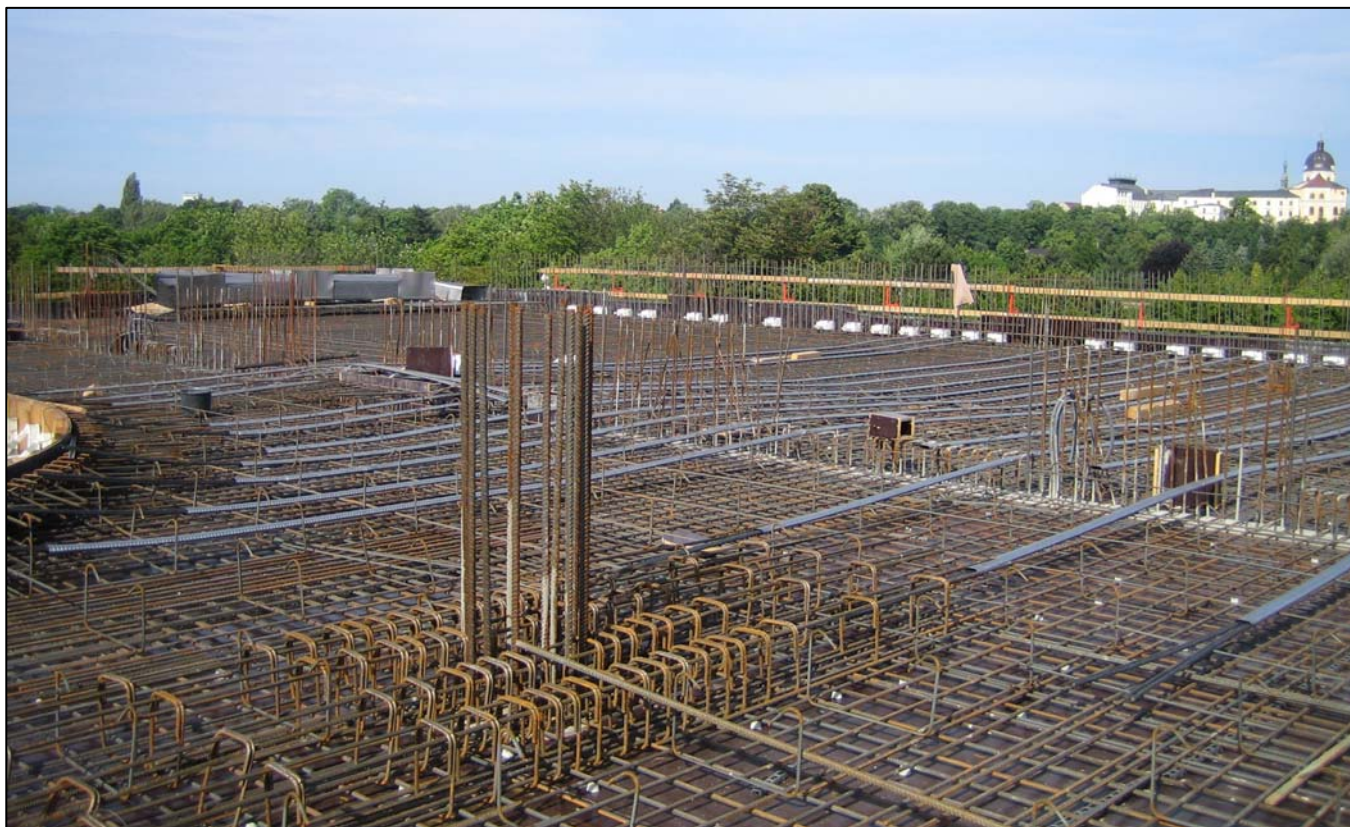
▲ Stropní deska v průběhu instalace předpínacích kabelů.
