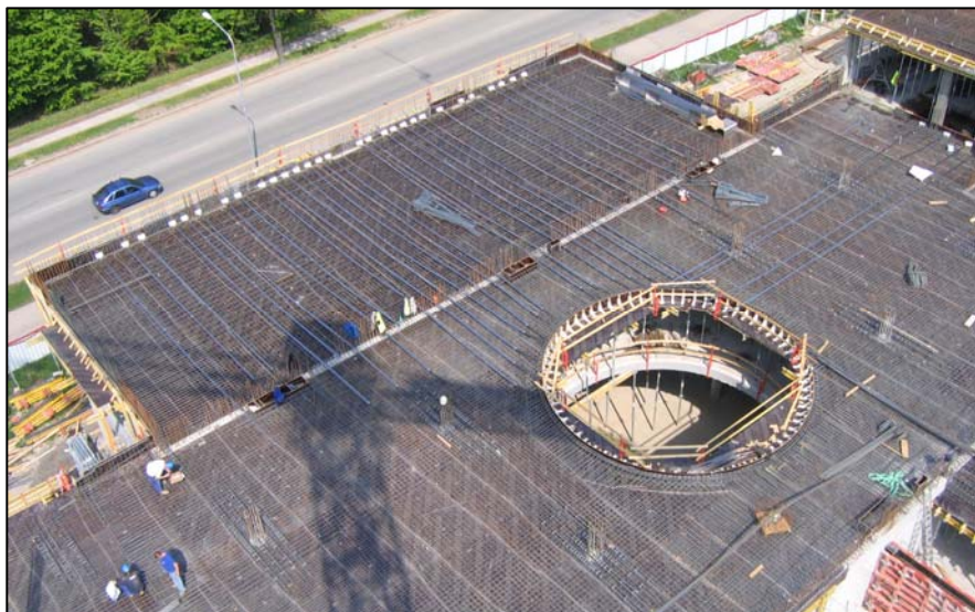
▲ Pohled na konstrukci z jeřábu.
