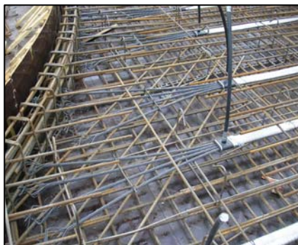
▲ Pasivní kotvy a odvodušňovací napojení.
