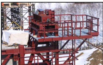
▲ Kluzné ložisko a boční vedení.
