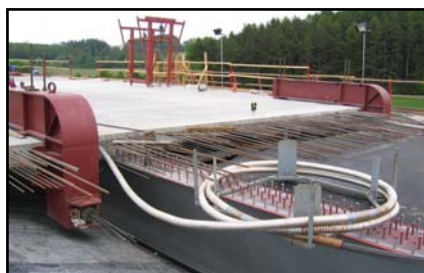
▲ Připojení tažných kabelů k desce.
