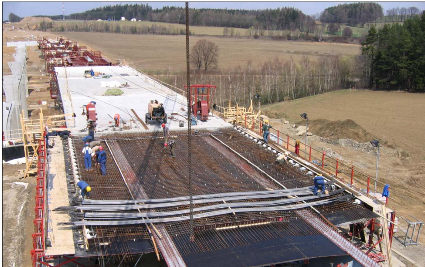
▲ Prefabrikace příčných kabelů SO 6-4.
