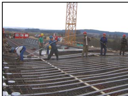
▲ Ukládka příčných kabelů.
