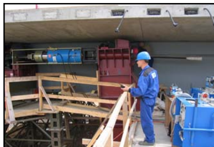
▲ Hladké čelo desky po injektáži kabelů.
