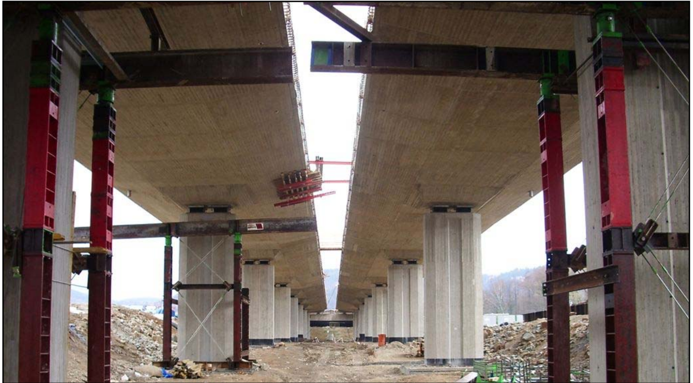
▲ Nosná konstrukce ve výstavbě.
