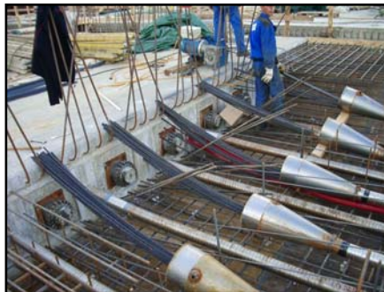
▲ Pracovní spára, kotvy & spojky.
