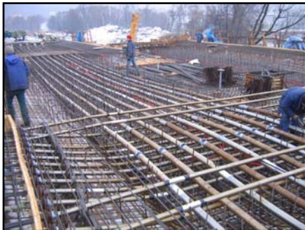
▲ Podélné a příčné předpínací kabely.
