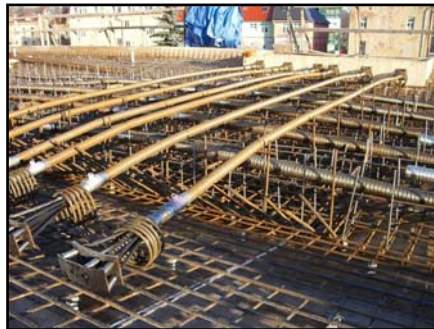
▲ Pasivní kotvy P 6-19.
