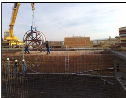
▲ Ukládání prefa kabelů pomocí autojeřábu.
