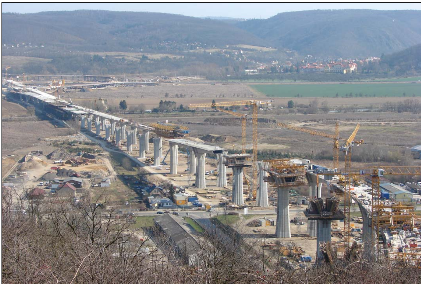
▲ Celkový pohled na přemostění v úseku „Stavba 514 Lahovice – Slivenec, SO 204“.
