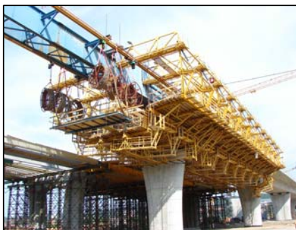
▲ Zavěšené cívky lan na výsuvné skruži.
