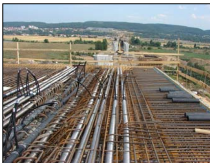
▲ Zárodek připravený k betonáži.
