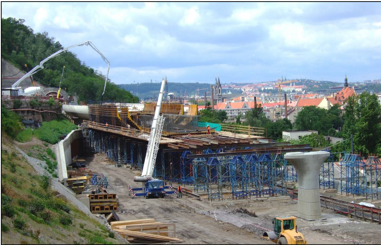
▲ Práce na typickém betonážním úseku.
