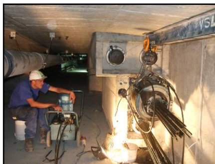
▲ Napínání externích kabelů délky 272m.
