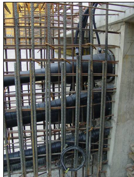
▲ Zajištěna kontinuita zapouzdření lan v plastu včetně pevných spojek K6-19.
