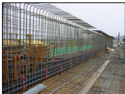
▲ Stěnové kabely s plastovými podložkami.
