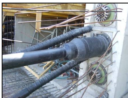
▲ Důsledná izolace je naprosto zásadní.
