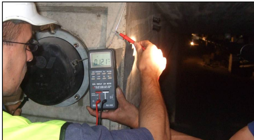
▲ Měření impedance mezi předpínací a měkkou výztuží, naměřená hodnota 12,1k \Omega .
