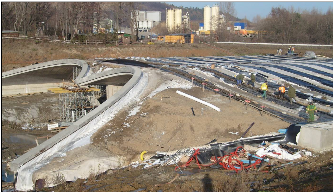
▲ Ukládka výztuže předpínaných pásů ekoduktu.
