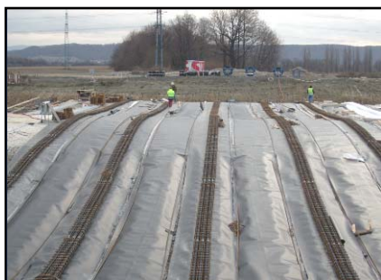
▲ Fáze před betonáží pásů.
