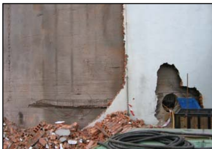
▲ Stav při ubourávání vnějšího zdiva.
