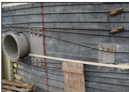
▲ Obepnutí nádrží kabely monostrand.
