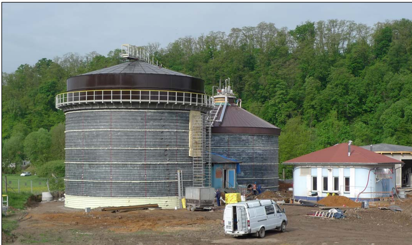
▲ Rekonstrukce vyhnívacích nádrží.
