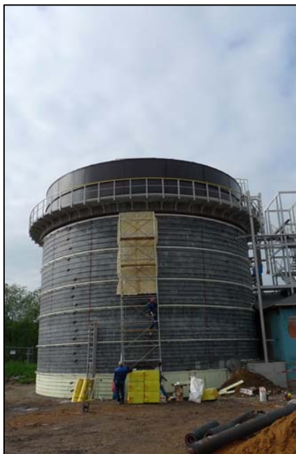
▲ Práce na nádrži VN2.
