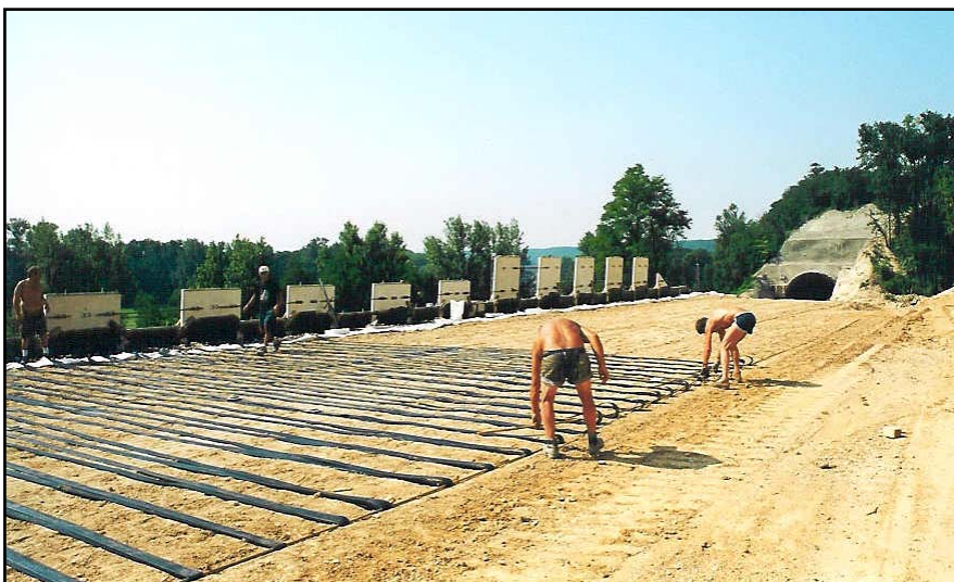
▲ Ukládka polymerových třecích kotev.
