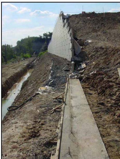
▲ Podkladní beton připravený pro ukládku 1. vrstvy stěnových dílců.
