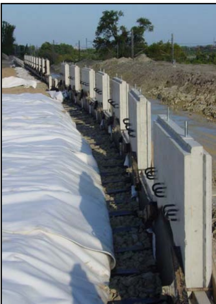
▲ Zadní líc konstrukce připravený pro ukládku drenážního zasypu.
