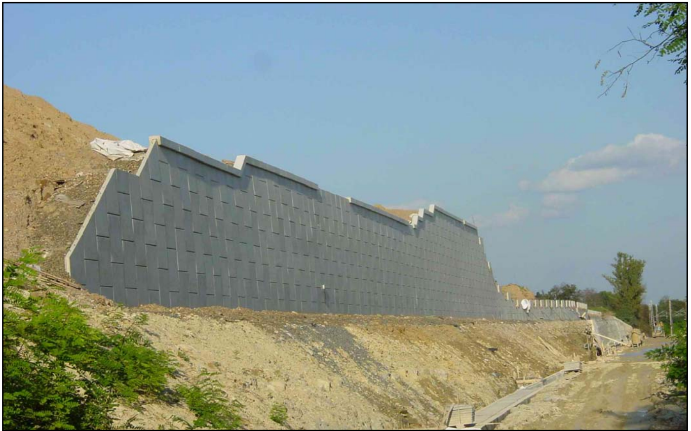
▲ VSoL opěrná stěna ve výstavbě
