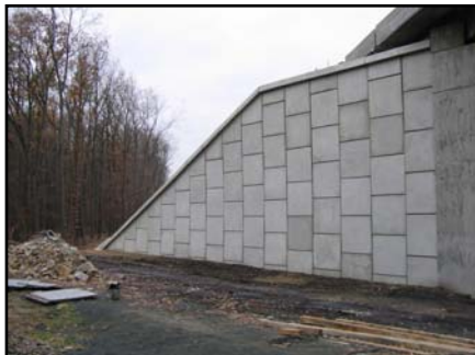
▲ Dokončené mostní křídlo u opěry 30.
