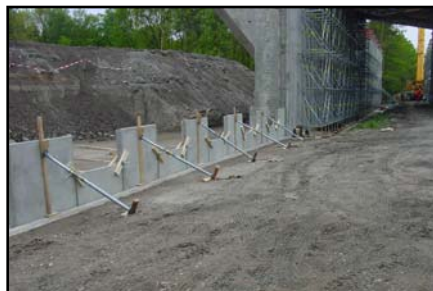
▲ Zajištění stability první řady panelů.
