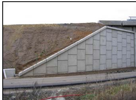
▲ Dokončené mostní křídlo u opěry 00.
