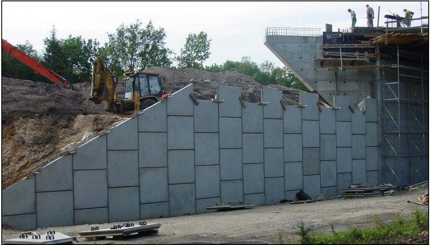
▲ VSoL při výstavbě.
