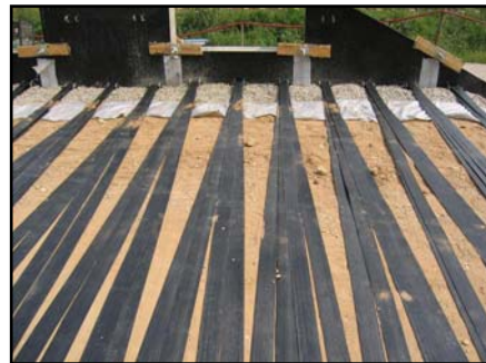
▲ Rozprostřené výztuhy před zahutněním.
