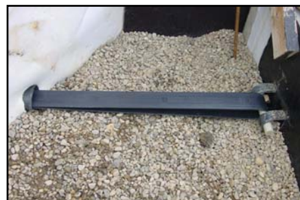
▲ Umístění průchočky v místě žb vzpěry.
