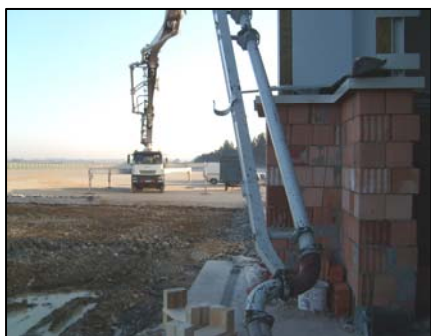
▲ Čerpání betonu na značnou vzdálenost.
