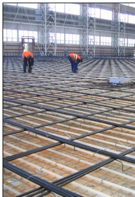
▲ Dokončování ukládání předpínacích kabelů.
