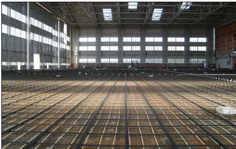
▲ Ukládka byla prováděna souběžně na několika úsecích.
