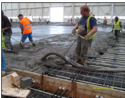
▲ Betonáž probíhala v 6-ti etapách.
