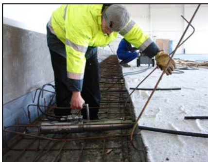
▲ Napínání kabelů ručním lisem.
