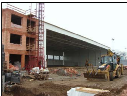
▲ Celkový pohled na rozestavěný objekt hangáru.
