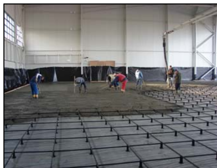
▲ Betonáž desky v jednom celku.
