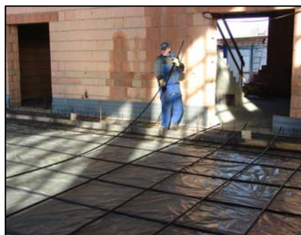
▲ Ukládání kabelů na ploše podlahy.
