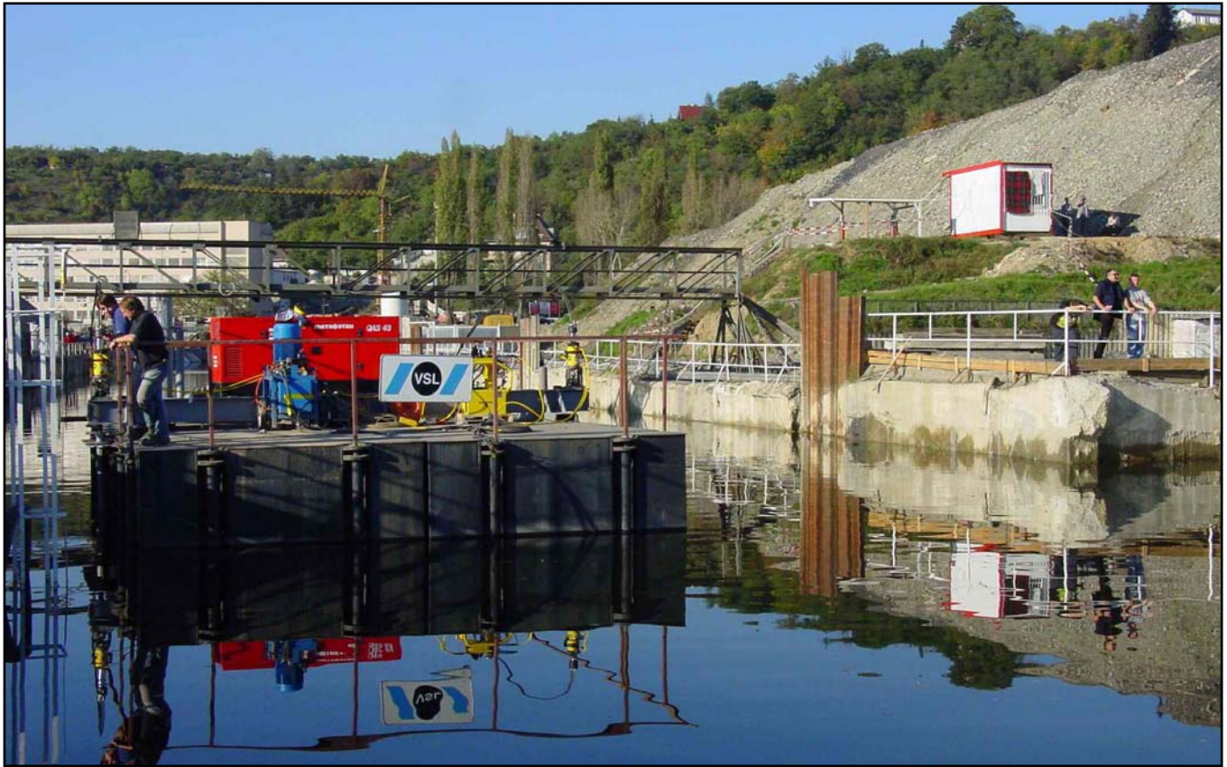
▲ Ponton pro zavěšení přední části tunelu na dvojici lanových závěsů
