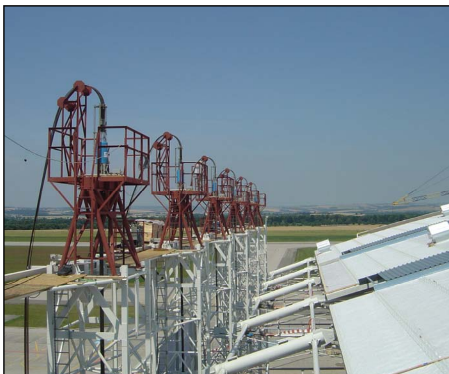
▲ Zvedací hydraulické jednotky VSL SLU 120/500 na zhlaví sloupů
