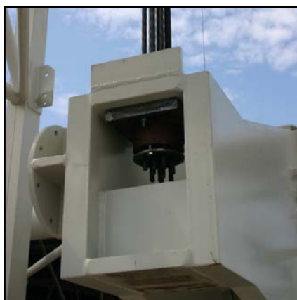
▲ Zakotvení lan pomocí kotevních objímk
