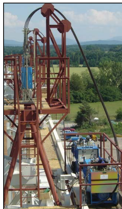
▲ Sloup s osazenou zvedací jednotkou VSL SLU 120/500.
