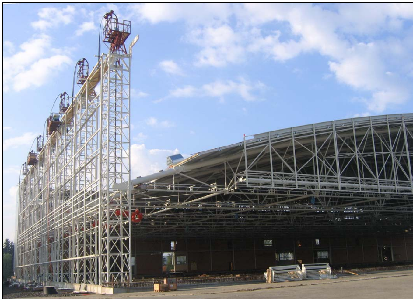
▲ Střecha hangáru při zvedání
