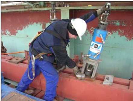
▲ Instalace hydraulické jednotky.
