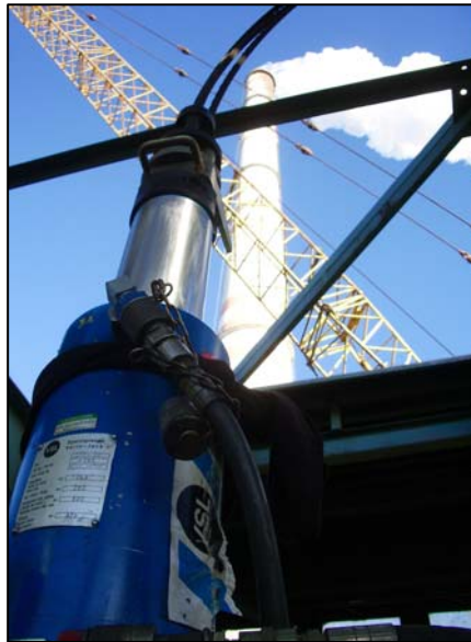
▲ Kotle A a B byly během prací v činnosti.
