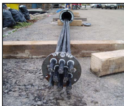
▲ Prefabrikace závěsů na mostovce
