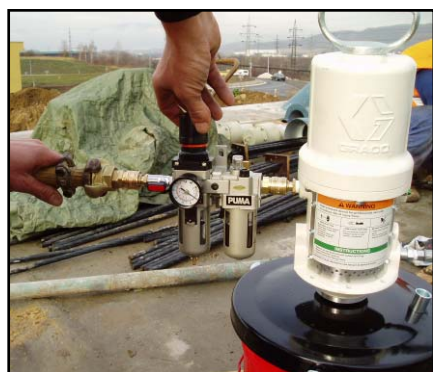
▲ Injektáž pasivních kotev tukem
