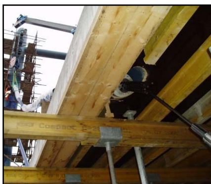
▲ Aktivace závěsu napnutím masterstrandu
