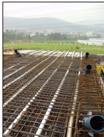
▲ Průchodky závěsů a kanálky předpínacích kabelů.
