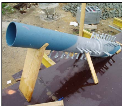
▲ Průchodka závěsu na bednění
