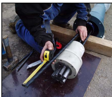
▲ Instalace pasivní kotvy závěsu
