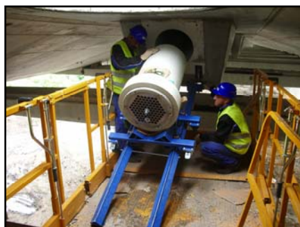
▲ Instalace aktivní kotvy do kotevního bloku
