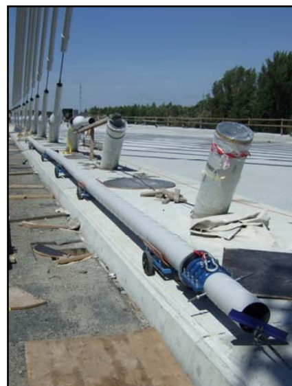
▲ HDPE chránička připravená k instalaci.
