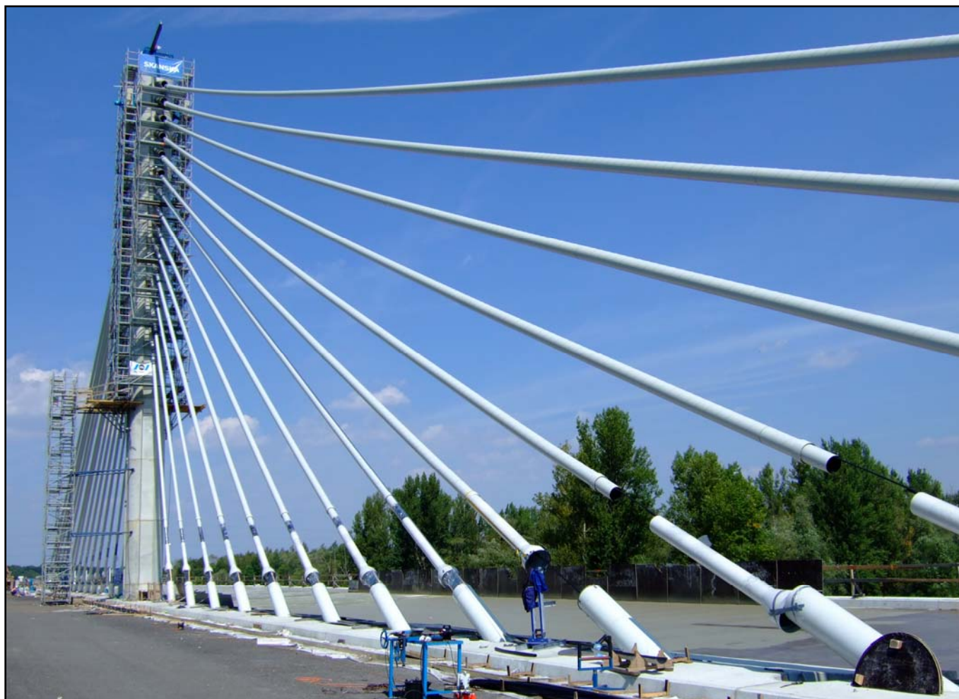
▲ Nainstalované chráničky závěsů
