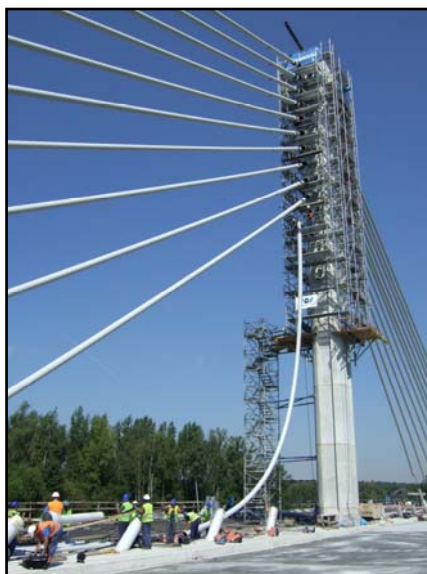
▲ Instalace HDPE chráničky
